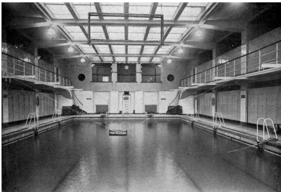
Obr. 78 Plavecký bazén v Klimentské ulici 694
