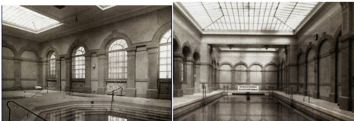
Obr. 96 Grössling 1914, vlevo relaxační část, pravo plavecký bazén 748
