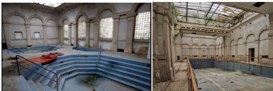
Obr. 95 Lázně Grössling v dnešní době, vlevo relaxační část, pravo plavecký bazén 747
