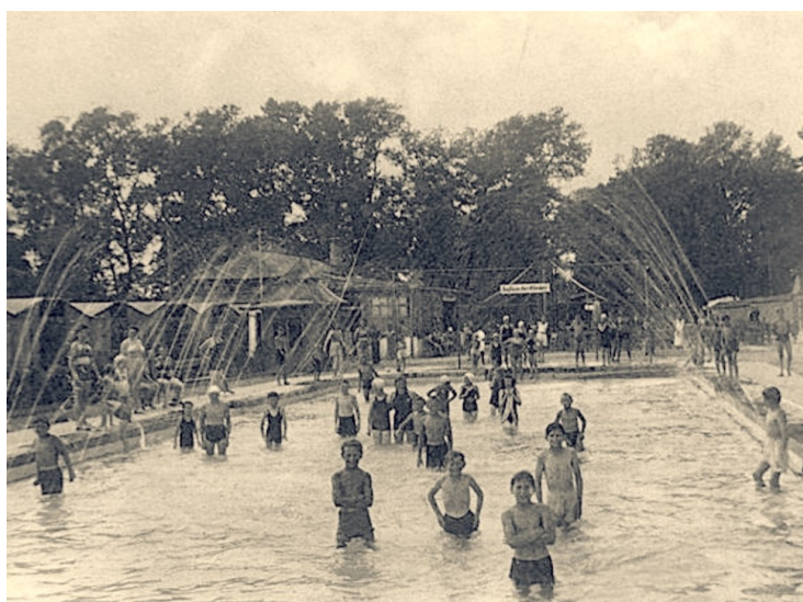
Obr. 98 Oblázková pláž nahoře a malý bazén s vodotrysky dole na koupališti Lido 751
